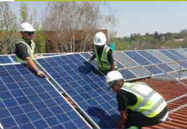
Sonpaneel-installasie in 2016 op VKB-hoofkantoor se dak
